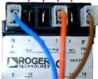
Le réglage de la puissance moteur se fait directement sur l'auto-transformateur.
